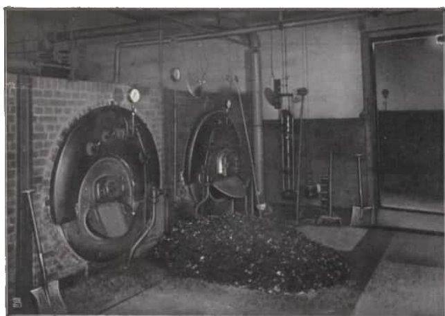
La « Salle des chaudières ». 211 salariés.
