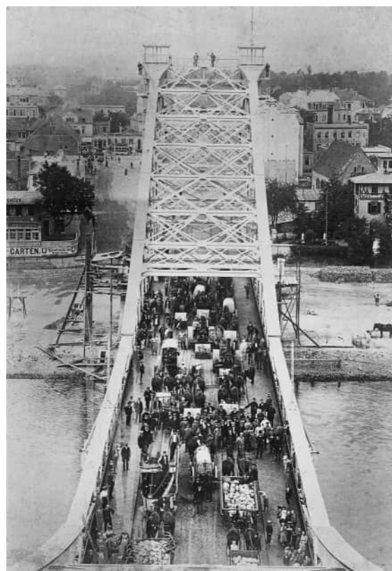
Essai de charge du pont, 1893.
