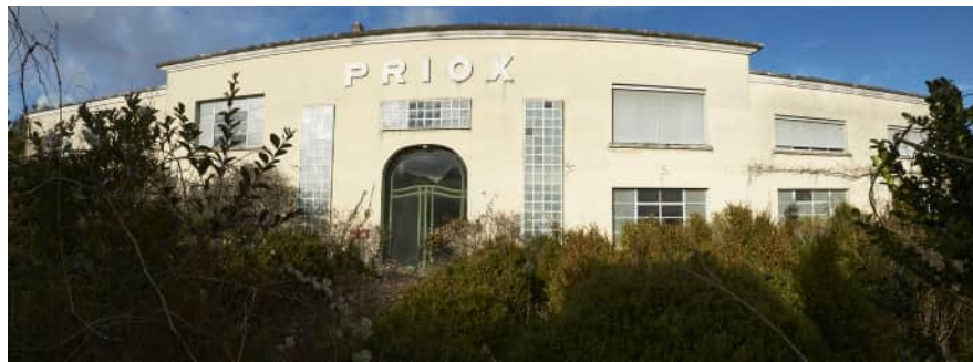
Façade de l'usine Priox à Chinon - Photographie Stéphane Muratet
