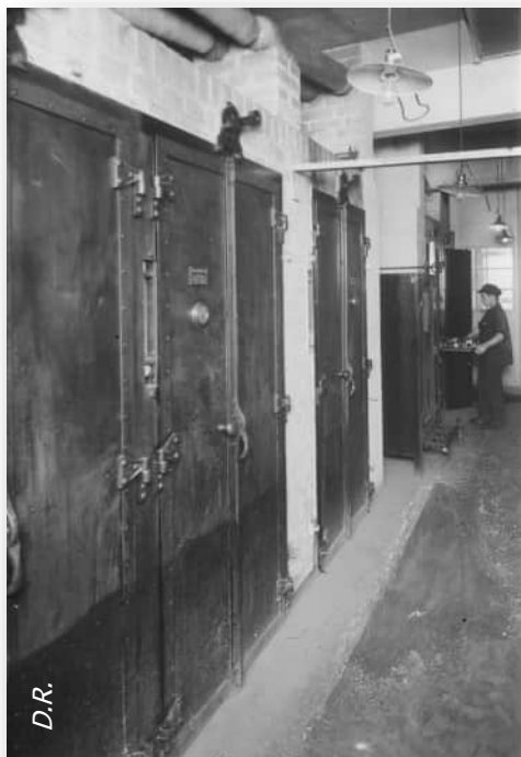
Cabines de séchage de la peinture
