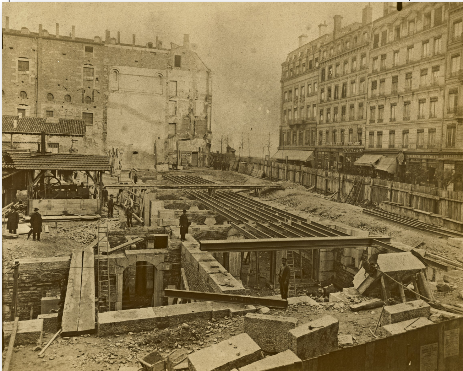
Construction de l'aile sud de l'Hôtel-Dieu, c.1890
