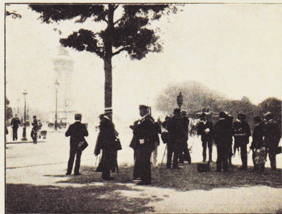
919. LA PRISE DU DERNIER CLICHÉ. LE PYLÔNE DU PONT ALEXANDRE III. Cliché LEANCOUR.
