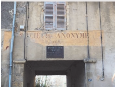
Entrée des bâtiments primitifs, état actuel. Remarquez la peinture annonçant la « Société Anonyme des Pellicules Françaises ».
