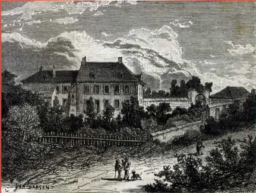
LA MAISON DU GRAS À SAINT LOUP DE VARENNES
